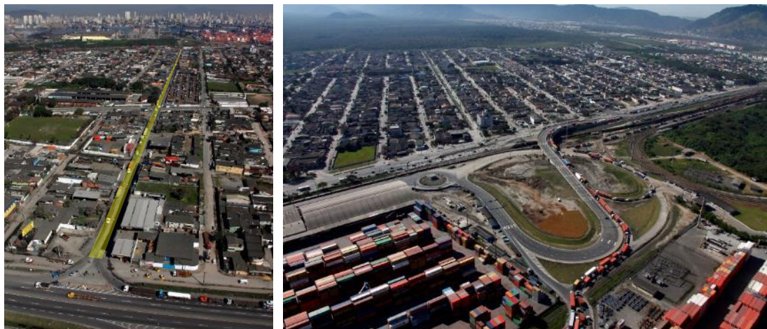
Figura 44 - Rua Idalino Pines (esq.), atual acesso rodoviário principal de entrada e saída da margem esquerda do Porto de Santos. Viaduto (dir.) de acesso aos terminais (dir.).
