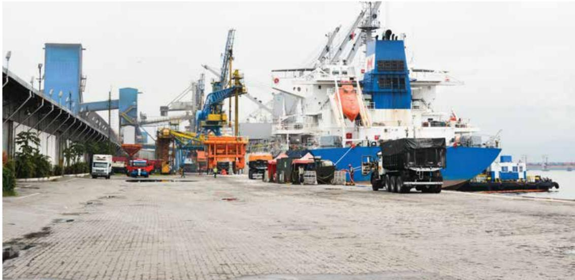
Os canteiros das obras de Recuperação e Reforço Estrutural do Cais entre os Armazéns 12A e 23 foram desmobilizados e o empreendimento foi concluído. O objetivo das obras foi garantir o equilíbrio do conjunto cais, estacas e solo durante a dragagem de aprofundamento. Para isso, foram necessárias obras de melhoria e recuperação das estruturas, uma vez que as antigas não seriam suficientes para estabilizar os berços com a profundidade de 15 metros.
