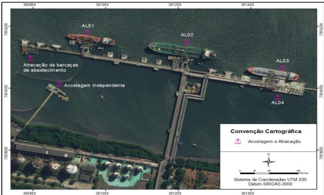
Figura 1 - Infraestrutura de acostagem dos terminais de grânéis líquidos da Alamoia. Fonte: Plano Mestre do Complexo Portuário de Santos (2019).
