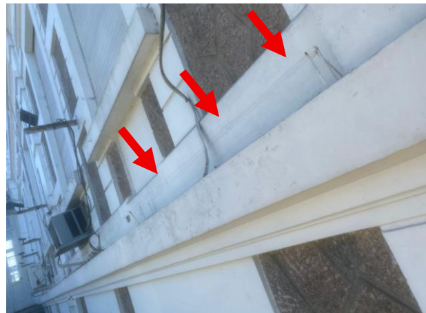
Figura 24 - Modelo de fio tensor instalado na Presidência.
