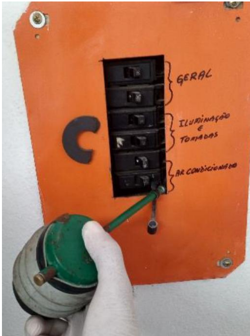
Figura 15 - Polvilhamento de pó inseticida em quadro de energia, para prevenção e controle de insetos rasteiros.
