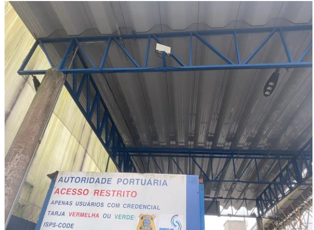
Figura 22 - Modelo de rede instalada na estrutura do Gate 14.
