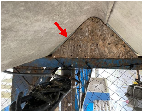
Figura 31 - Modelo de tapume de madeira instalado em Gate.
