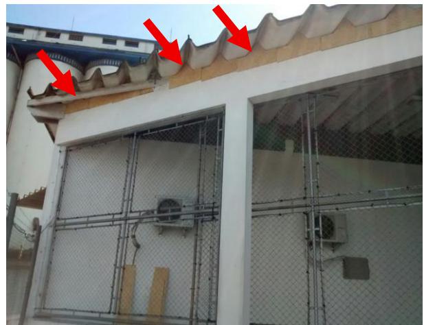
Figura 32 – Instalação de tapumes para evitar a entrada de pombos.
