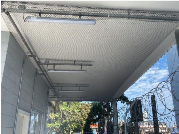
Figura 21 - Modelo de rede instalada na estrutura do Gate 18.
